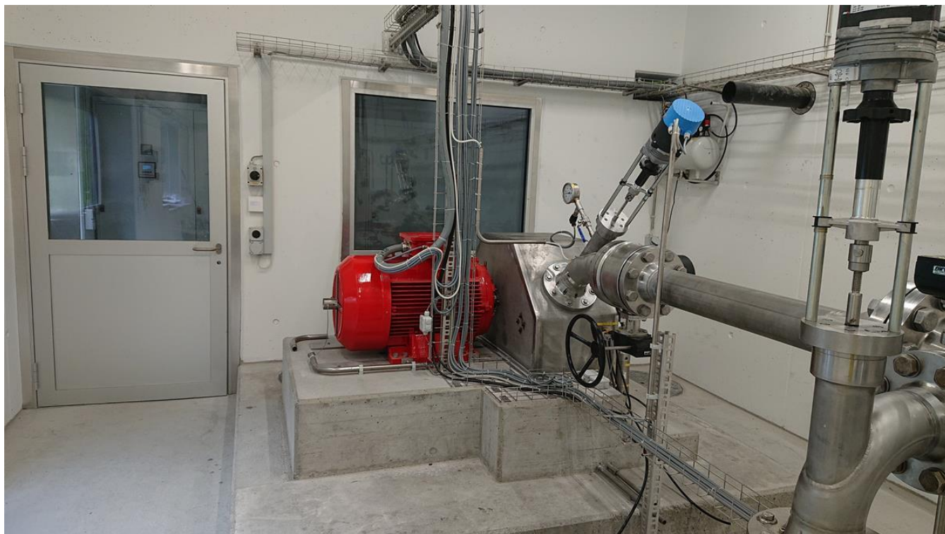
Bild Abwasser Uri: Abwasserturbine und Generator der Druckreduktion in Göschenen (Ableitung Abwässer Urner Oberland). Die Anlage produziert jährlich rund 310'000 kWh Ökostrom.
