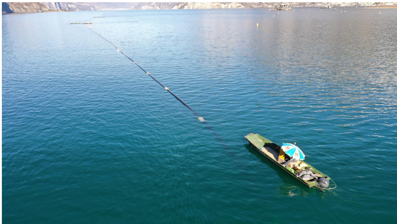
Bild BINARY one GmbH: Am 8. Februar 2022 war es soweit. Die Abwasserleitung zwischen Seedorf und Isleten konnte erfolgreich auf den Grund des Urnersees abgesenkt werden.
