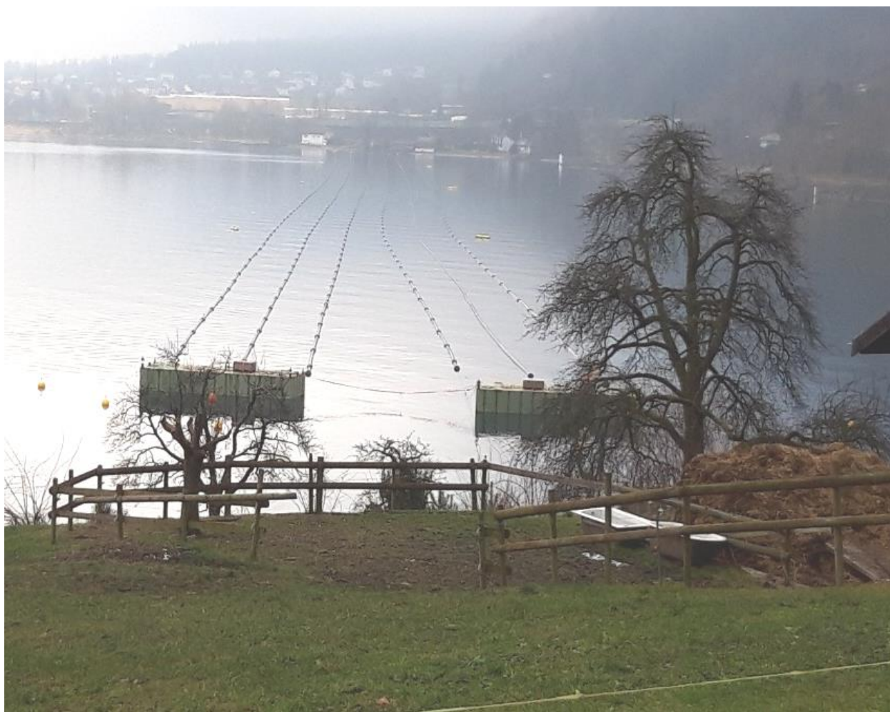
Bild Abwasser Uri: Die Seeleitung für den Abschnitt Seedorf nach Isleten liegt im Seelager zwischen Seehof und Bolzbach auf dem Urnersee bereit. Am 8. Februar 2022 wurden die sechs Leitungsstränge miteinander verbunden und kontrolliert auf den Seegrund abgesenkt.
